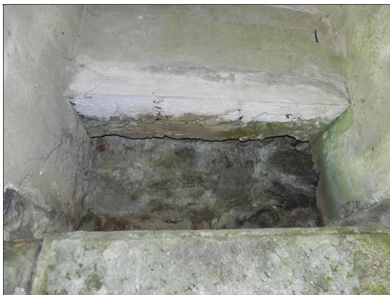
Zatékání na příčník nad OP1 - PS
