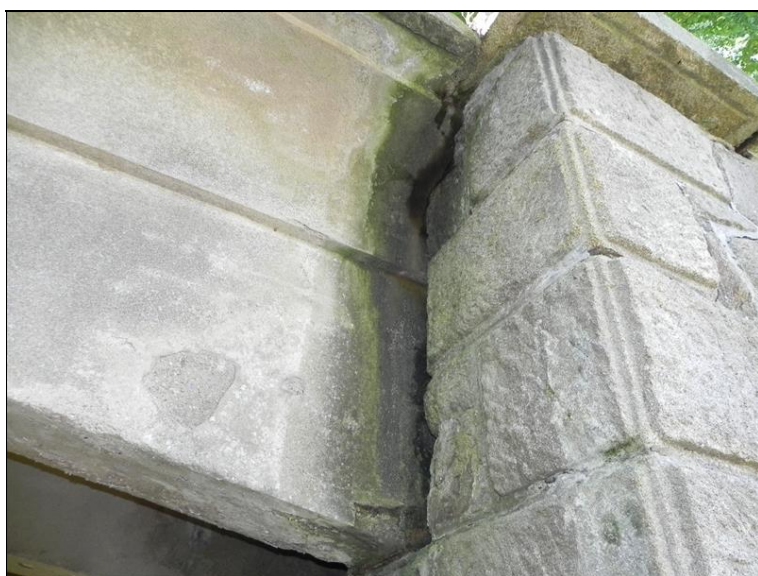
Zatékání na NK v místě dilatace - pravá strana
