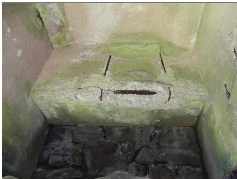
Odhalená korodující výztuž v příčníku nad OP1
